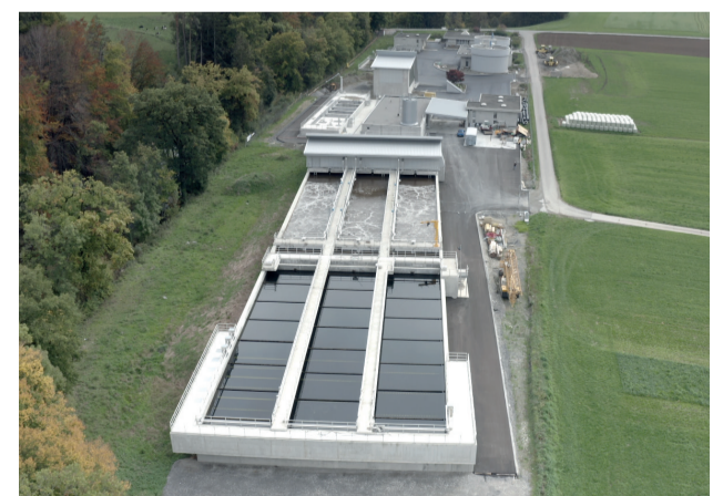
Vue aérienne de la Station d'épuration d'Ecublens © Franco DeAndrea
