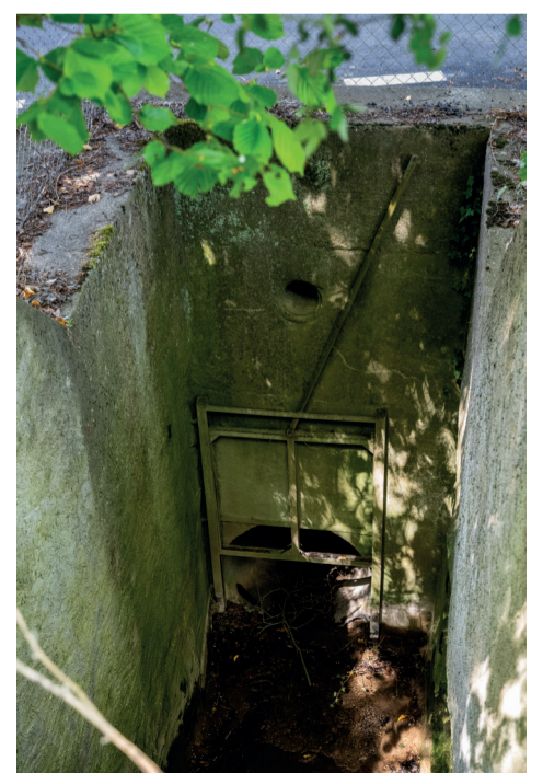
L'écluse et réserve d'eau pour les pompiers © Charly Jaquier
