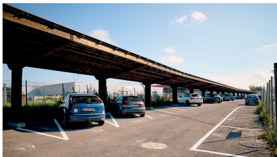
Le parking de Nyon © Sirbatec SA
